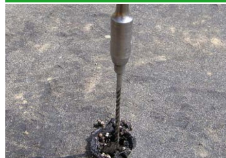
03 | Předvrtání otvoru pro kotevní prvek
